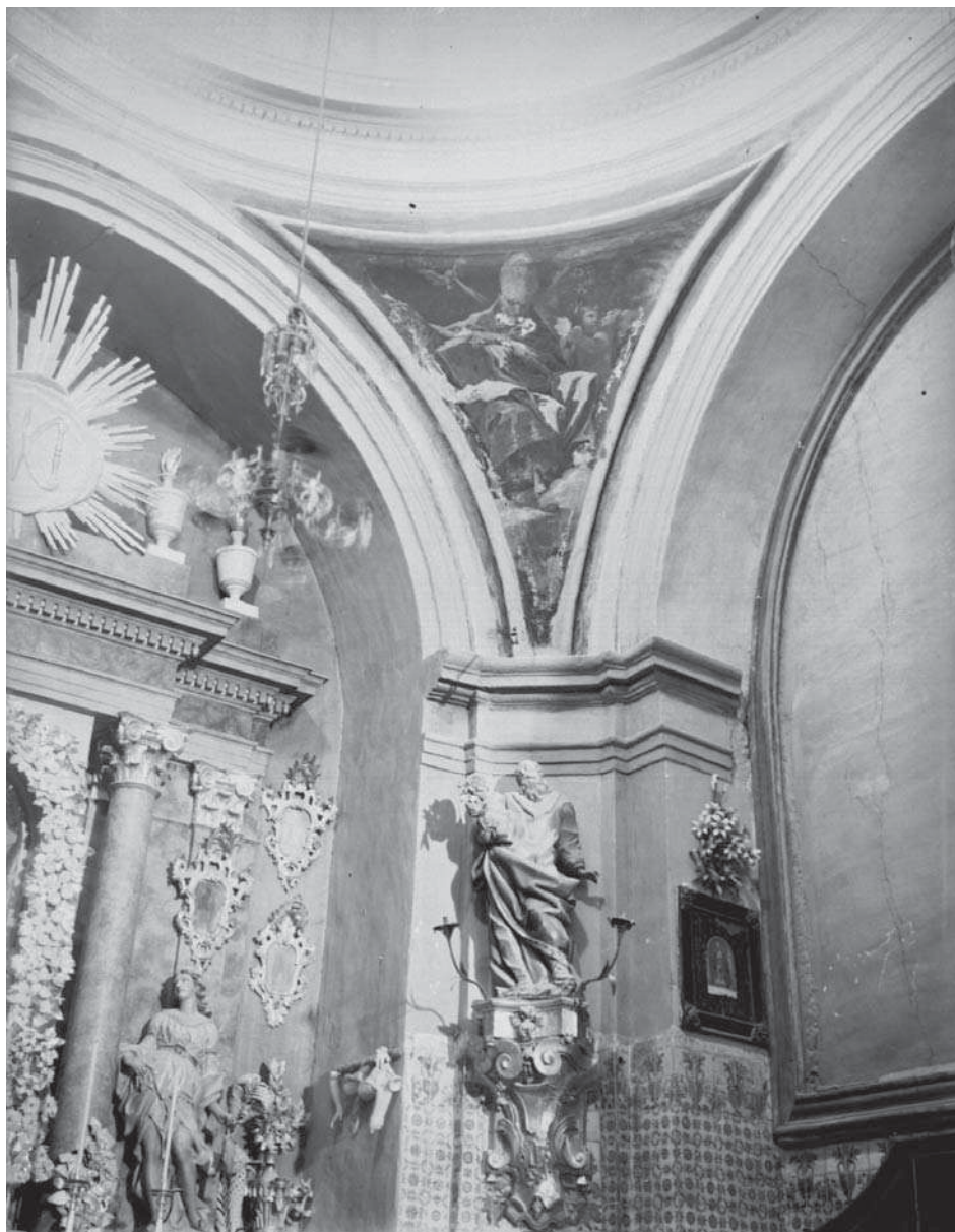
Fig. 3: Ermita de N.ª S.ª de la Fuente, Muel (Zaragoza), imagen retrospectiva del presbiterio. Archivo fotográfico «José Galiay». Archivo Histórico Provincial de Zaragoza-Gobierno de Aragón, núm. 132.
